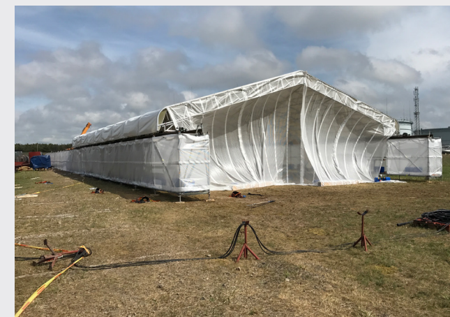
Būtingės naftos terminalas | Palanga
