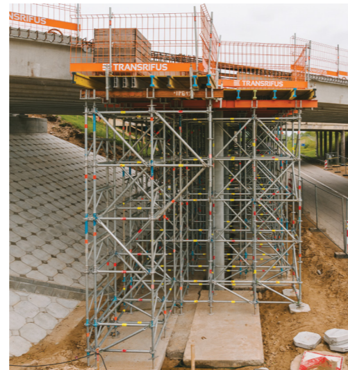
Valstybinės reikšmės magistralinio kelio A2 Vilnius-Panevėžys viadukas | Ukmergės r.
